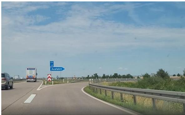
Abbildung 9: Ausfädelungsfahrstreifen von BAB A 14 zur BAB A 14 (Blickrichtung Norden)
